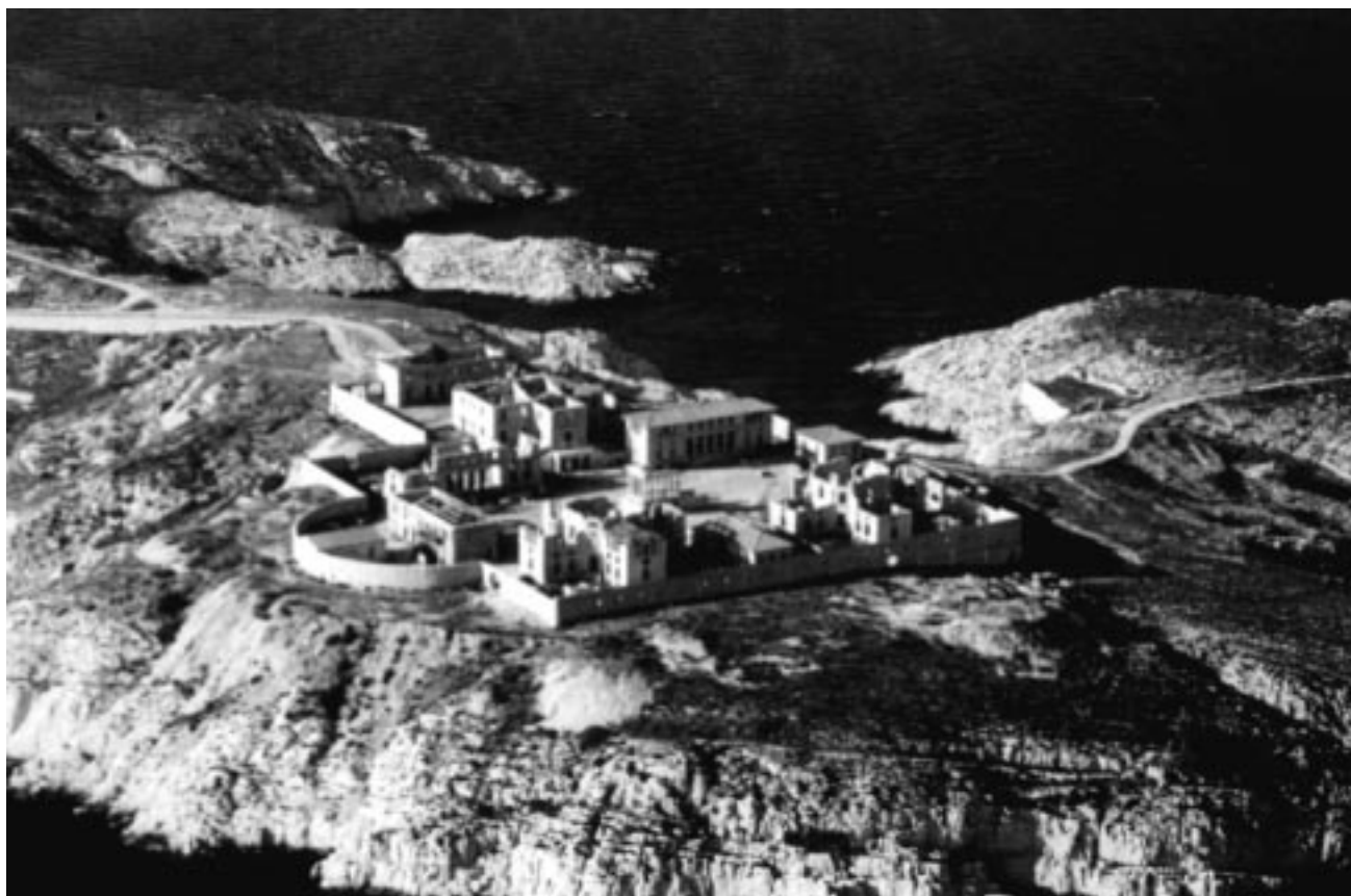
Figure 3 - Vue aérienne de l'hôpital-lazaret Caroline sur les îles du Frioul au large de Marseille.
